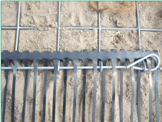
Tensar-Geogitter wird mit Steckstab an das Winkerelement durch wechselseitiges fädeln gekoppelt.
