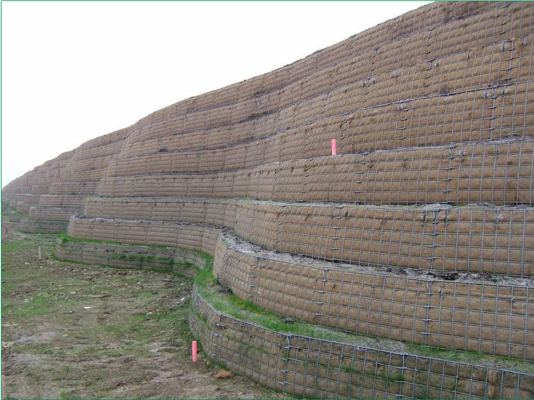
Bauwerk nach Fertigstellung
