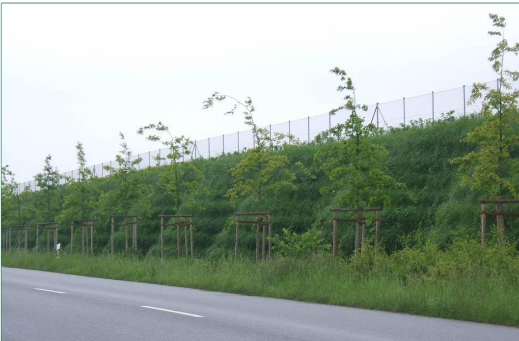
Bauwerk ca. 18 Monate nach Fertigstellung
