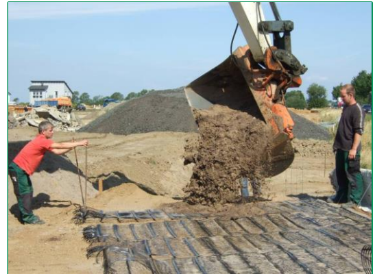
Tensar-Geogitter vor Verfüllung spannen.
